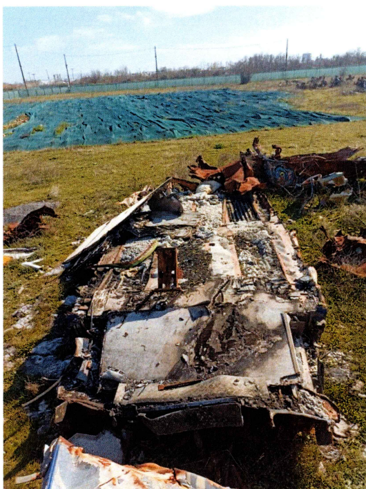
Δύο τμήματα του κυλικείου. Εμφανείς οι επιπτώσεις καύσης με διάρκεια και σταθερή ενταση.
