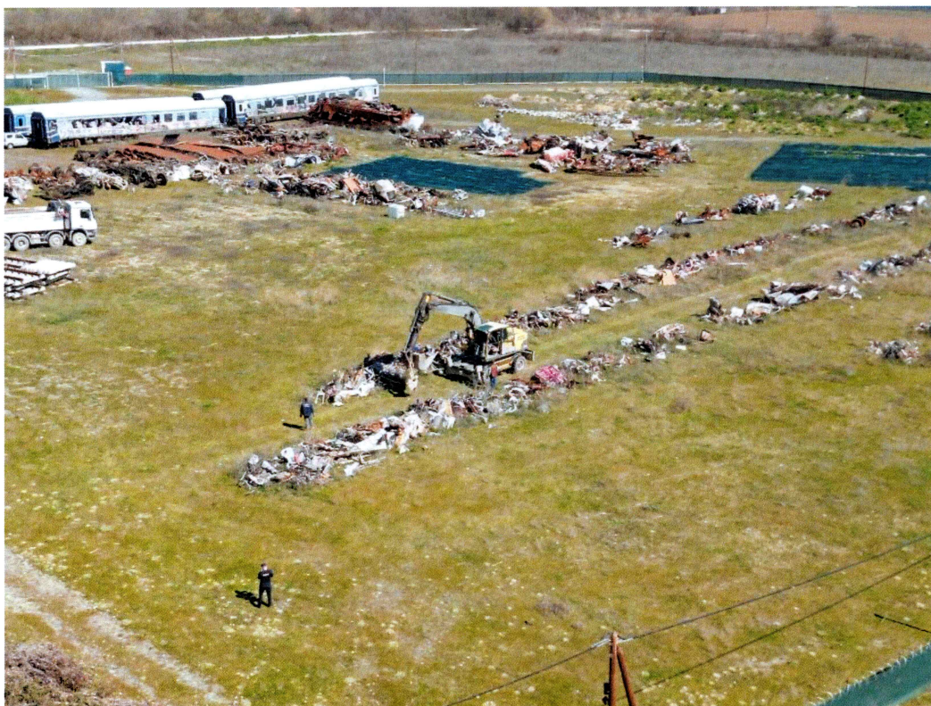
Μετακίνηση τμημάτων συντριμμιών με τη συνδρομή χωματουργικού μηχανήματος.
