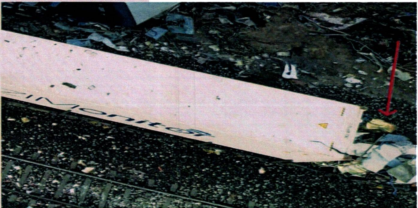
Υπολείμματα δοχείου μεταφοράς τολουολίου σε καινούργιο φορτίο επί του βαγονιού ,αφού το προηγούμενο φορτίο μεταφορτώθηκε σε αμαξοστοιχία που ήλθε για το σκοπό αυτό. Το δοχείο έχει το χρώμα που θα έπαιρνε ανοξειδωτο κιβώτιο που εκτέθηκε σε υψηλή θερμοκρασία
