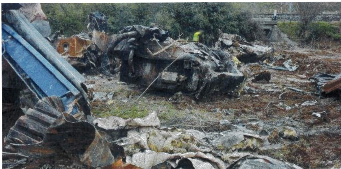
Εικόνα 14: Μετασχηματιστής της Η/Α 120 023 όπου φαίνεται η αλυσοειδής γραμμή επαφής πάνω στον μετασχηματιστή - αρχείο: 20230305_184147.jpg
