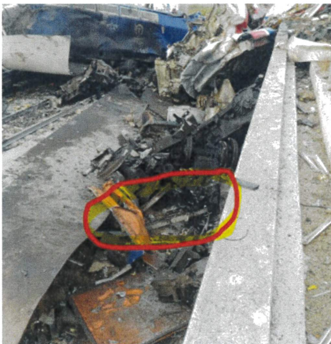
Εικόνα 11: Στόλος αλυσσοειδούς γραμμής επαφής της γραμμής καθόδου role κάτω από την εμπορική ηλεκτράμαξα (2023-03-01 16.46.00.jpg)
