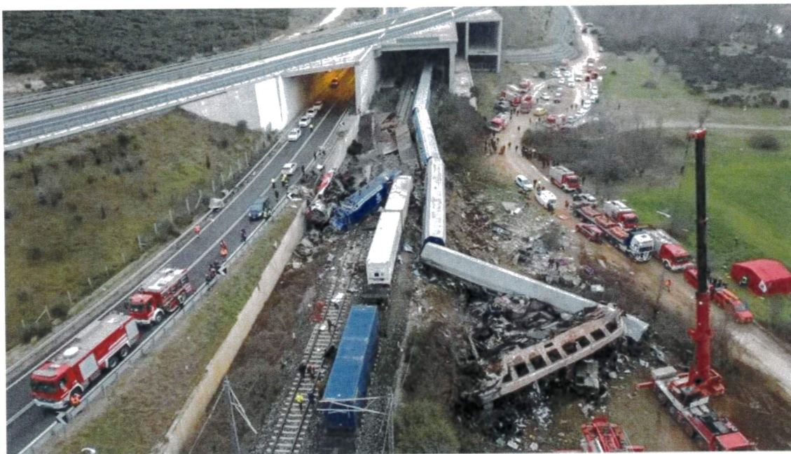
Εικόνα 10: Γενική άποψη των θέσεων των οχημάτων μετά την σύγκρουση
