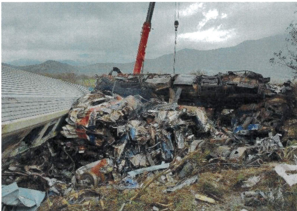
Εικόνα 21: Συντρίμμια γύρω από τον μετασχηματιστή και την εστία της φωτιάς - φάκελος: 230301_073502.jpg
