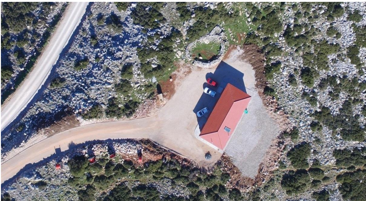
Εικόνα 1: Πανοραμική όψη τυπικού Οικίσκου Ελέγχου σε Αιολικό Πάρκο.
