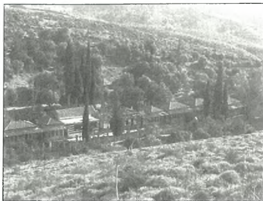
Εικ. 46: Στη δεξιά πλευρά του συγκροτήματος, διακρίνεται το περίπτερο Καλβοκορέση (φωτ. Α. Μιχαηλίδη)
