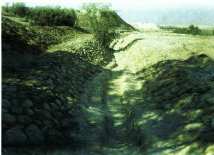
13 Β. Ο πυθμένας του υδραγωγείου στη βορειοανατολική πλευρά της μεγάλης δεξαμενής
