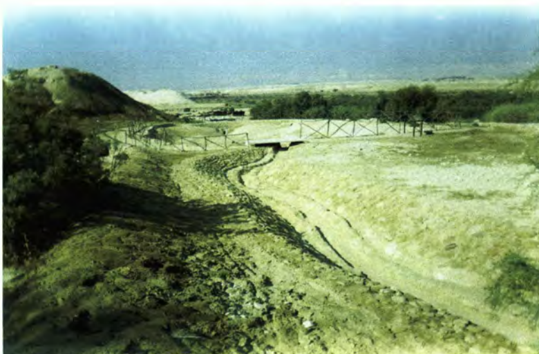
13 Α. Γενική άποψη του υδραγωγείου στη βορειοανατολική πλευρά της μεγάλης δεξαμενής
