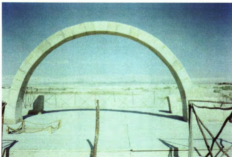
22 Α. Γενική άποψη του νότιου ναού (Αψιδωτός Ναός) μετά την αποκατάστασή της αφίδας
